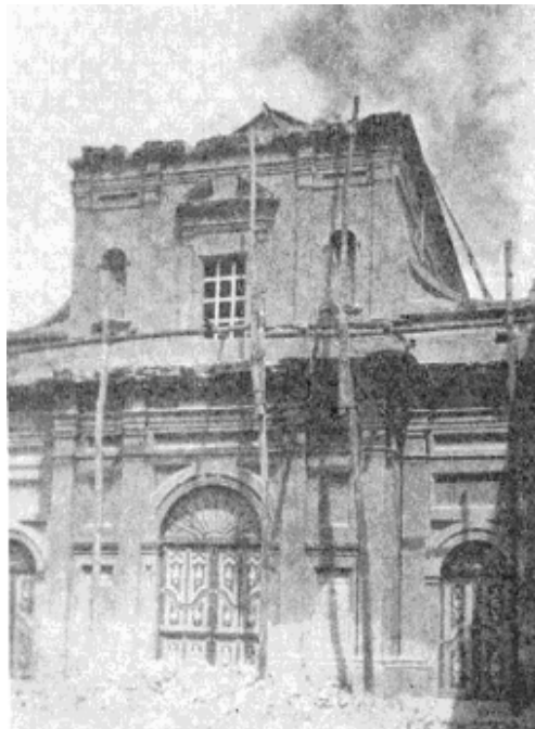
Figura 6. Capilla del Hospital San Pedro después del sismo del 14 de Julio de 1947 (Ramírez, 1948).
